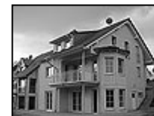
Einfamilienhaus in Dabringhausen
