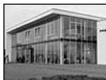
Bürogebäude in Neuss
