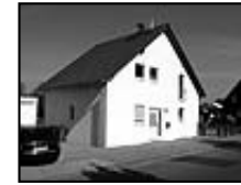
Einfamilienhaus in Tönisvorst
