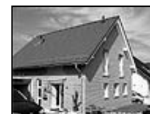
Einfamilienhaus in Roetgen
